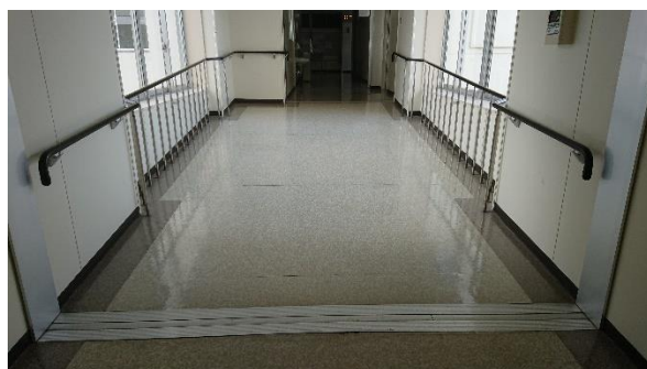
教室棟への廊下にスロープを設置
